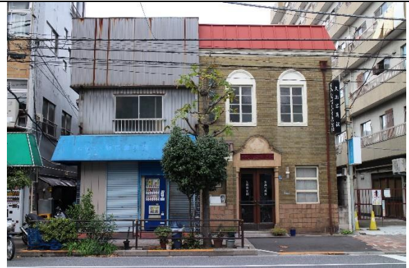
旧矢島写真館（東京都台東区）
