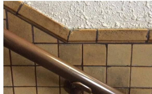
階段周りのタイル張り腰壁。白壁との見切り 部に付近には、台形のタイルを制作して 張っている。タイル寸法は約60×60、台形 のものは、60×90程度の大きなものから カットして施釉し、焼成。湿式成形品。
