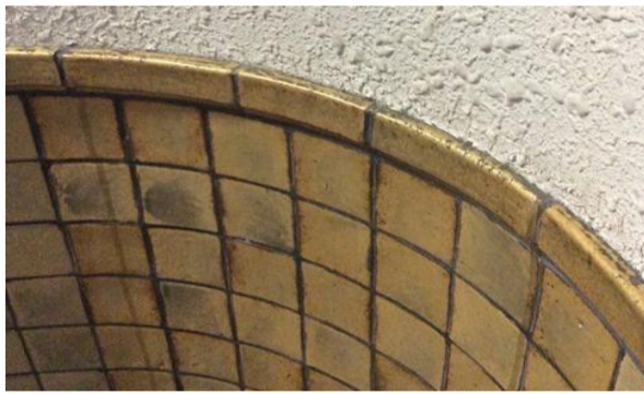
階段周りのタイル張り腰壁。内反りのR平 ボーダーが使われている。ボーダー寸法は 幅：35 長さ90、120
