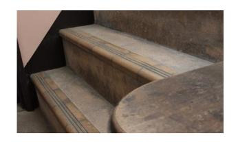
内装でタイルが使われている部分は階段の 段鼻と廊下のコーナー部に使われているほ かはコンクリート壁ペンキ塗装仕上げだ け。
