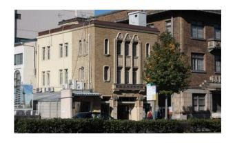
大津橋分室に隣接して建造されている。奥の白っぽい壁の部分はセメントモルタル吹付仕上げ。窓枠は同じものだが窓周りの装飾は外壁の仕上げと同様簡素化されている。
