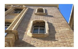
窓周りにはタイルは使われておらず、人造石に砂入り塗料を吹き付けた(不詳)ような仕上げの装飾材で仕上げてある。
