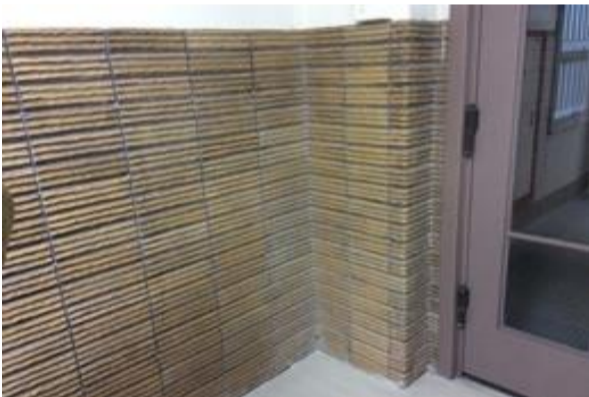
食堂・売店前の廊下のタイル 三角の谷・山を持つ横縞釉掛タイル(湿式成形) 寸法：65×237～240
