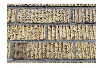
スクラッチ加工ののち施釉。ワラビと呼ばれる引っ掻き跡を軽く押さえて表面を 平らにしてある。特に大きな跡の場合は 焼成後に剥離して素地色がのぞくためこ うした押さえが必要。
