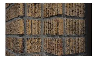
建物のコーナー部分のタイル使いは、 曲りなどの役物タイルは使わず、約1 8 mmほどのタイルの小端面に釉薬を 掛けた平物を使って納めてある。役物 は平滑なものでも平物の3倍の価格だ が、スクラッチ加工のものはより手間 がかかる。
